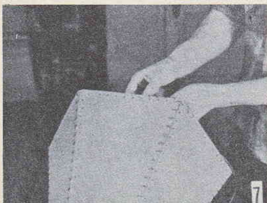
Fig. 7 - Una fase più avanzata della copertura, a questo punto tutte le facce sono già state messe a dimora ed unite tra di loro nonché agli elementi verticali della struttura metallica, qui, viene iniziata l'applicazione della fettuccia lungo i bordi orizzontali, superiore ed inferiore della copertura. Fig. 8 - Completamento del fissaggio delle facce; come si può vedere tale operazione non ha richiesto l'impiego di adesivo, in quanto tutto il fissaggio è stato eseguito con la fettuccia.
